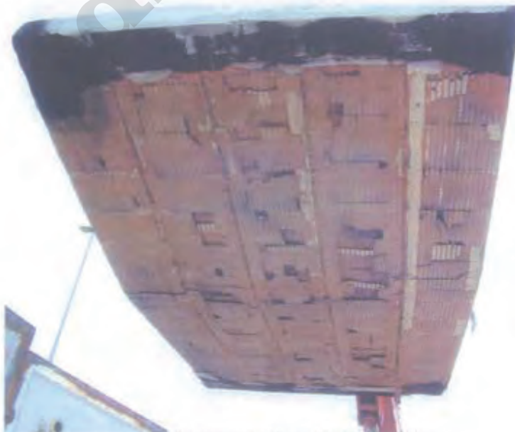
Foto 2. Lato esposto al fuoco del solaio dopo la prova
